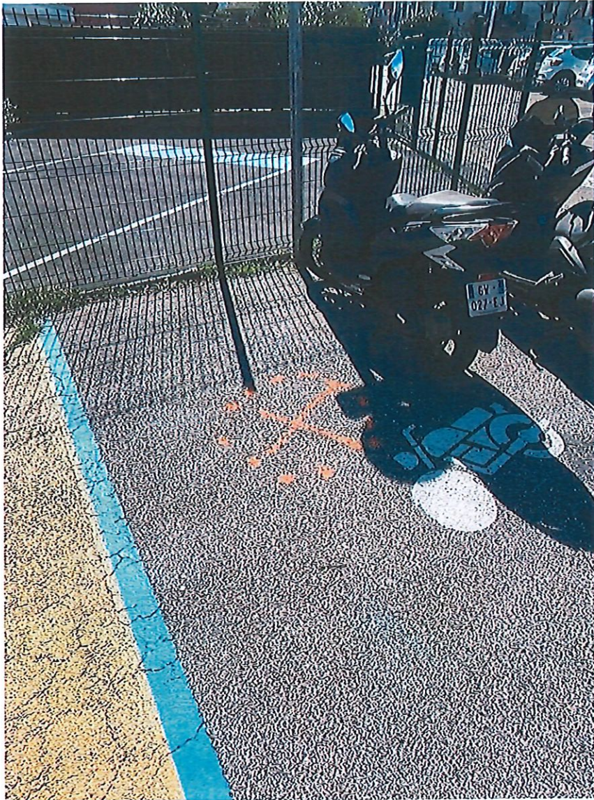
« Photo n°1 : Localisation des travaux de mise à la côte »
