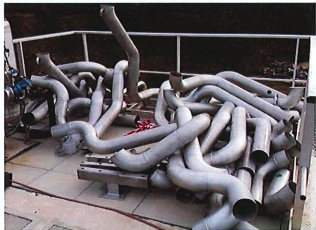
Canalisation d'aération en INOX préfabriquée avant mise en place
